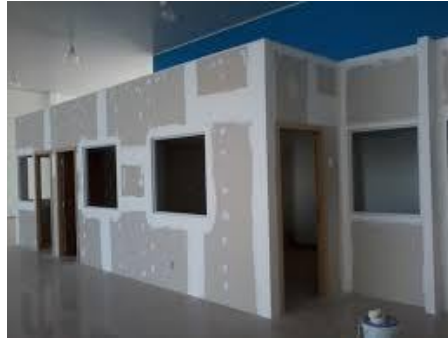
Divisórias em placas de gesso acartonado com perfis metálicos .
