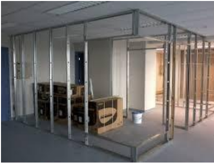
Divisórias em placas de gesso acartonado com perfis metálicos .
